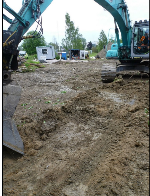
Tutkimusalueen koilliskulmaa kaivetaan. Kuvassa erottuva hiekkamaa on peräisin täytetystä kaukolämpöputken kaivannosta.
